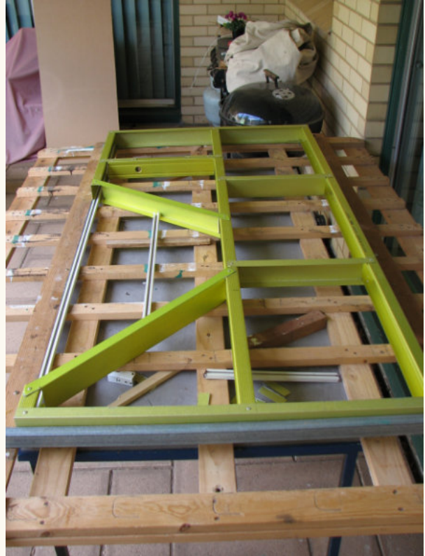
Fig. 3 The metal stud frame work
